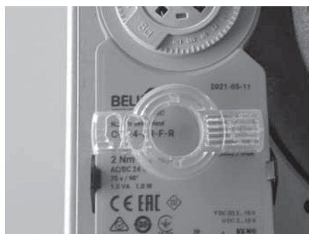
Abb. 4.32 Kupplung entriegelt
