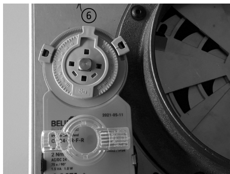
Abb. 1.24 Moottori suunnilleen keskikohtaan asetettuna, ilmaventiili auki normaalia lämmityskäyttöä varten
