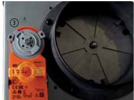
Abb. 7.23 Motorstellung links, Luftventil geschlossen
