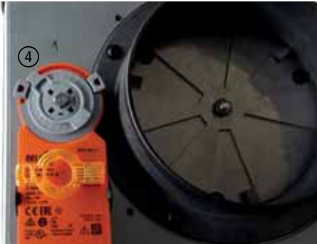
Abb. 7.16 Motorstellung links, Luftventil geschlossen
