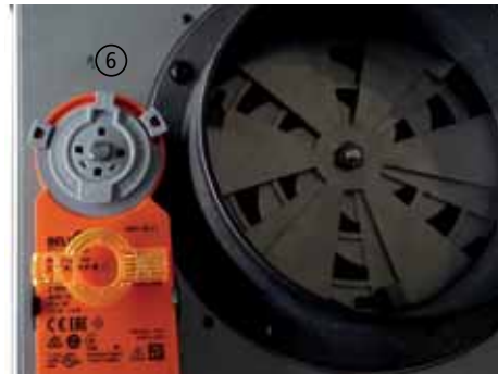
Abb. 7.18 Motorstellung ca. Mitte, Luftventil für normalen Heizbetrieb geöffnet
