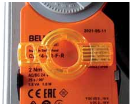
Abb. 7.15 Kupplung entriegelt
