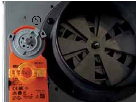
Abb. 7.17 Motorstellung rechts, Luftventil in Anheizstellung
