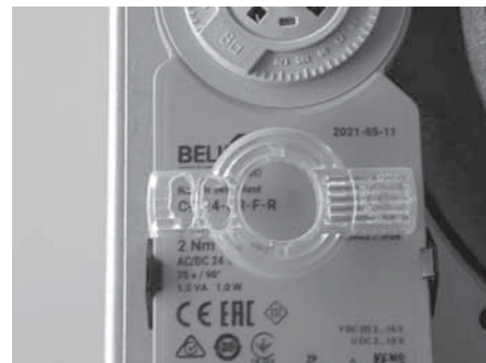
Abb. 4.19 Kupplung entriegelt
