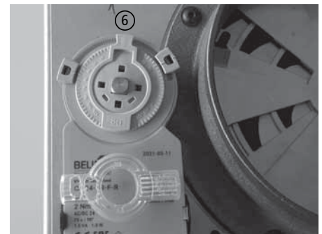
Abb. 4.32 Motorstellung ca. Mitte, Luftventil für normalen Heizbetrieb geöffnet
