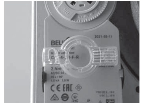
Abb. 4.29 Kupplung entriegelt
