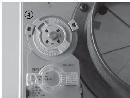
Abb. 4.30 Motorstellung links, Luftventil geschlossen
