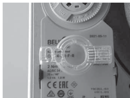
Abb. 4.29 Kupplung entriegelt
